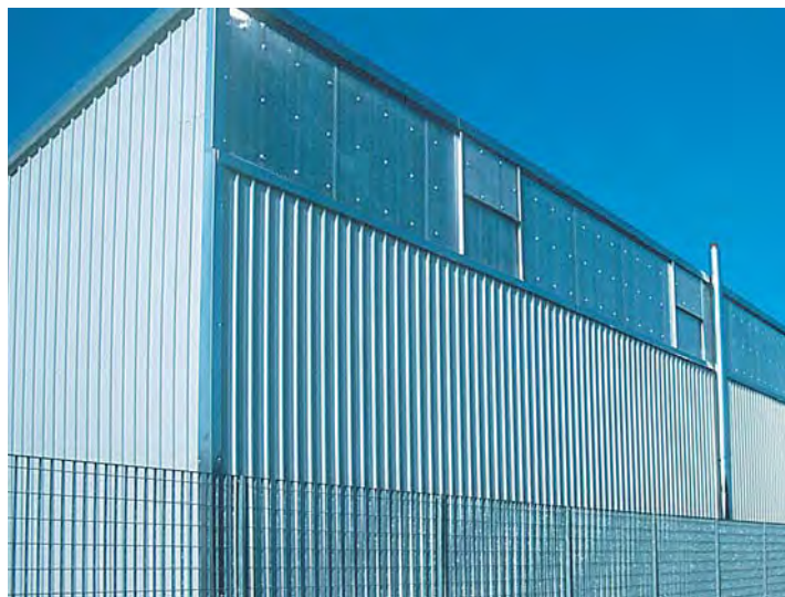
Tamponamento verticale con lastra Etruria
