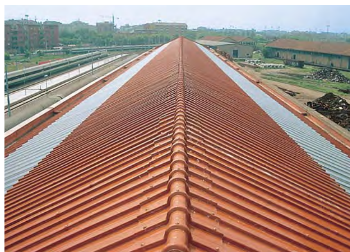
Applicazione di lastra Etruria con colmo
